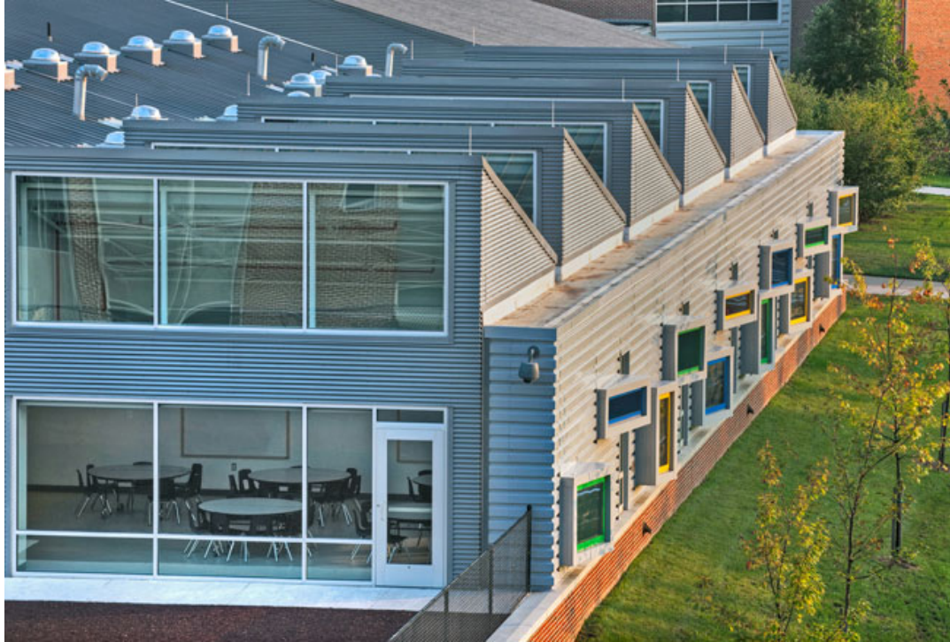
Testere dişli çatı dilimleri kuzey pencereleri ve sınıflara güneşiği sağlayan güneş tüplerini barındırıyor. Foto © VMDO Architects/Prakash Patel
